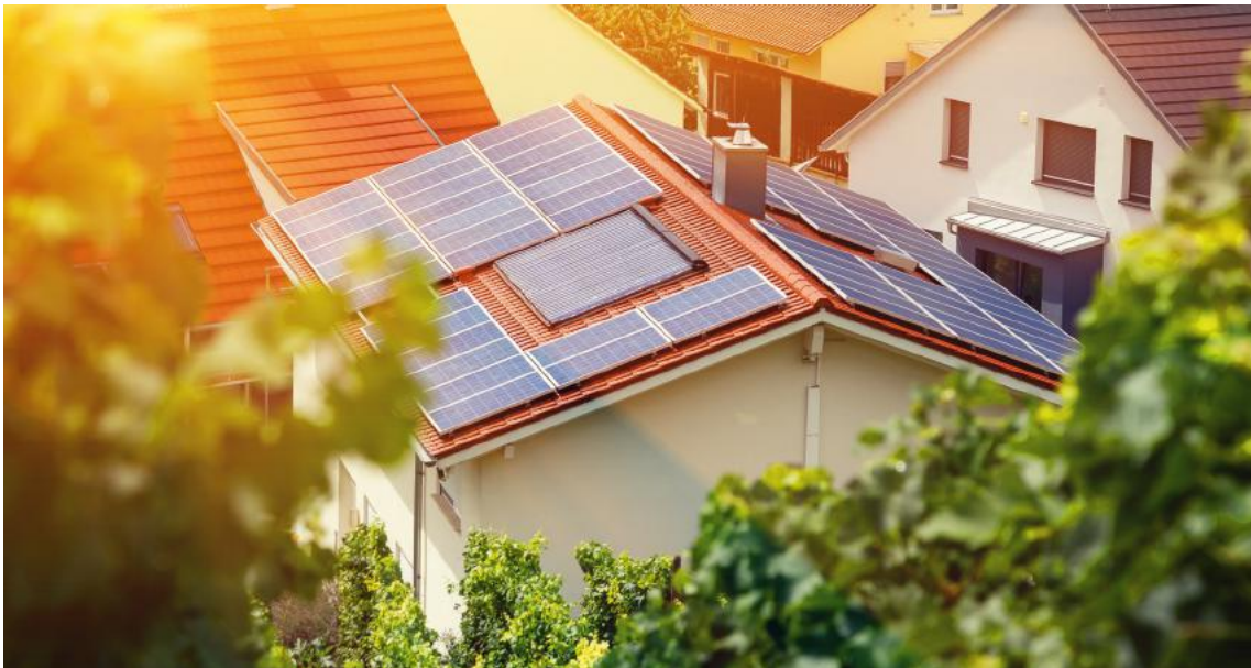
Solarthermieanlagen für Warmwasser und Heizung werden auf dem Dach installiert. Die direkte Umwandlung von Sonnenlicht in Wärme spart viel Energie und ist sehr effektiv.
