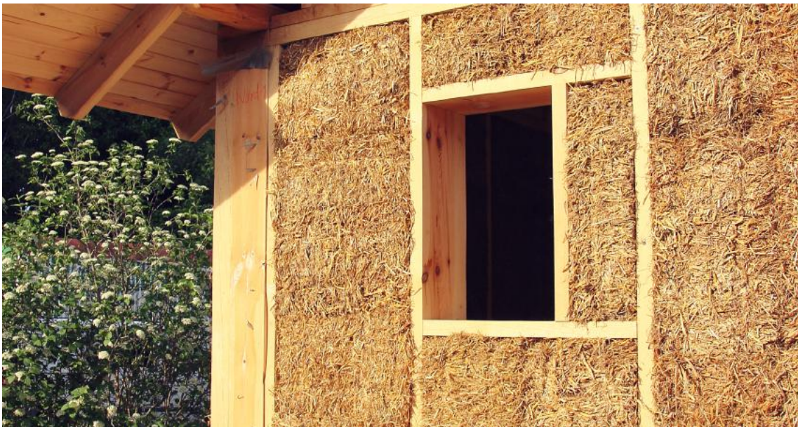
Ein Haus, das mit Hilfe von Strohballen gedämmt wird, heißt Strohballenhaus. Es wird in aller Regel aus Holz gebaut, dann mit Stroh gedämmt und mit Lehm verputzt. Die Naturmaterialien sorgen für ein angenehmes Raumklima und gute Luftwerte im Inneren.
